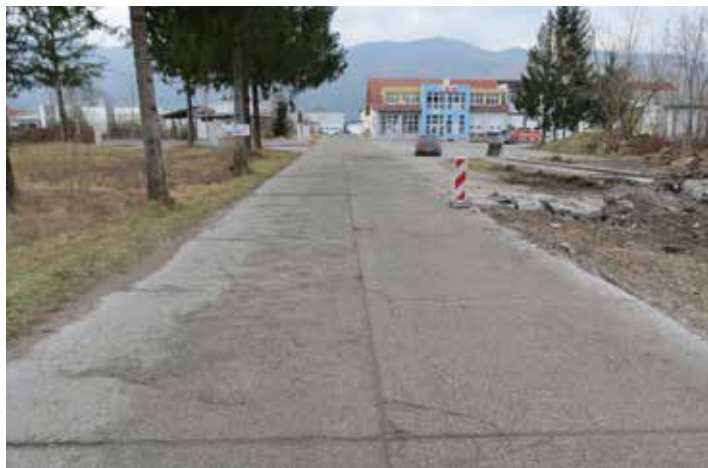
Vhod v OC Ugar pred rekonstrukcijo. Foto Danilo Hočevar
