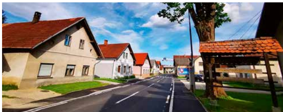
Prenova Gorenjske ceste
